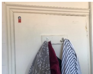
Asbestolux door panel
