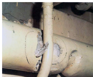
Asbestos pipe lagging
