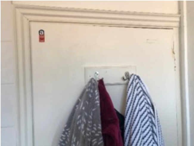
Asbestolux door panel
