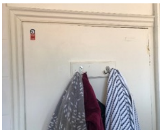
Asbestolux door panel
