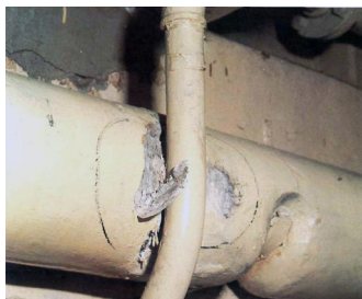
Asbestos pipe lagging
